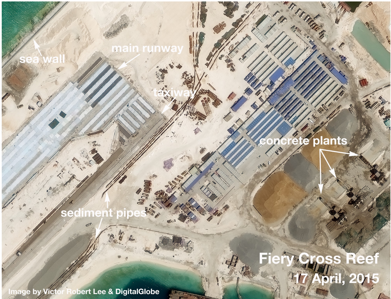
Ảnh 16: Cận cảnh các công trình đang được xây trên bãi Chữ Thập. Nguồn: CSIS Asia Maritime Transparency Initiative / DigitalGlobe
