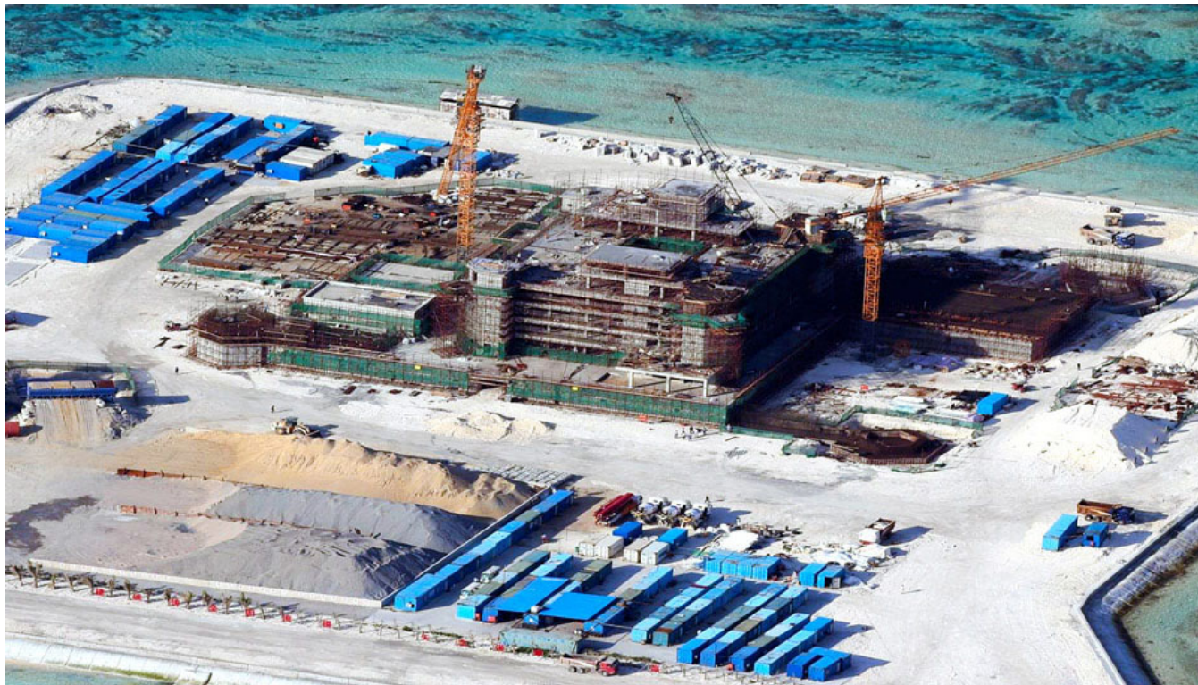
Ảnh 24: Cận cảnh các công trình xây dựng đang được xây trên nền đảo nhân tạo trên bãi Châu Viên. Nguồn ảnh: Asahi Shimbun.
