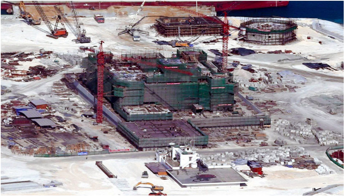
Ảnh 23: Cận cảnh các công trình xây dựng đang được xây trên nền đảo nhân tạo trên bãi Châu Viên. Nguồn ảnh: Asahi Shimbun.
